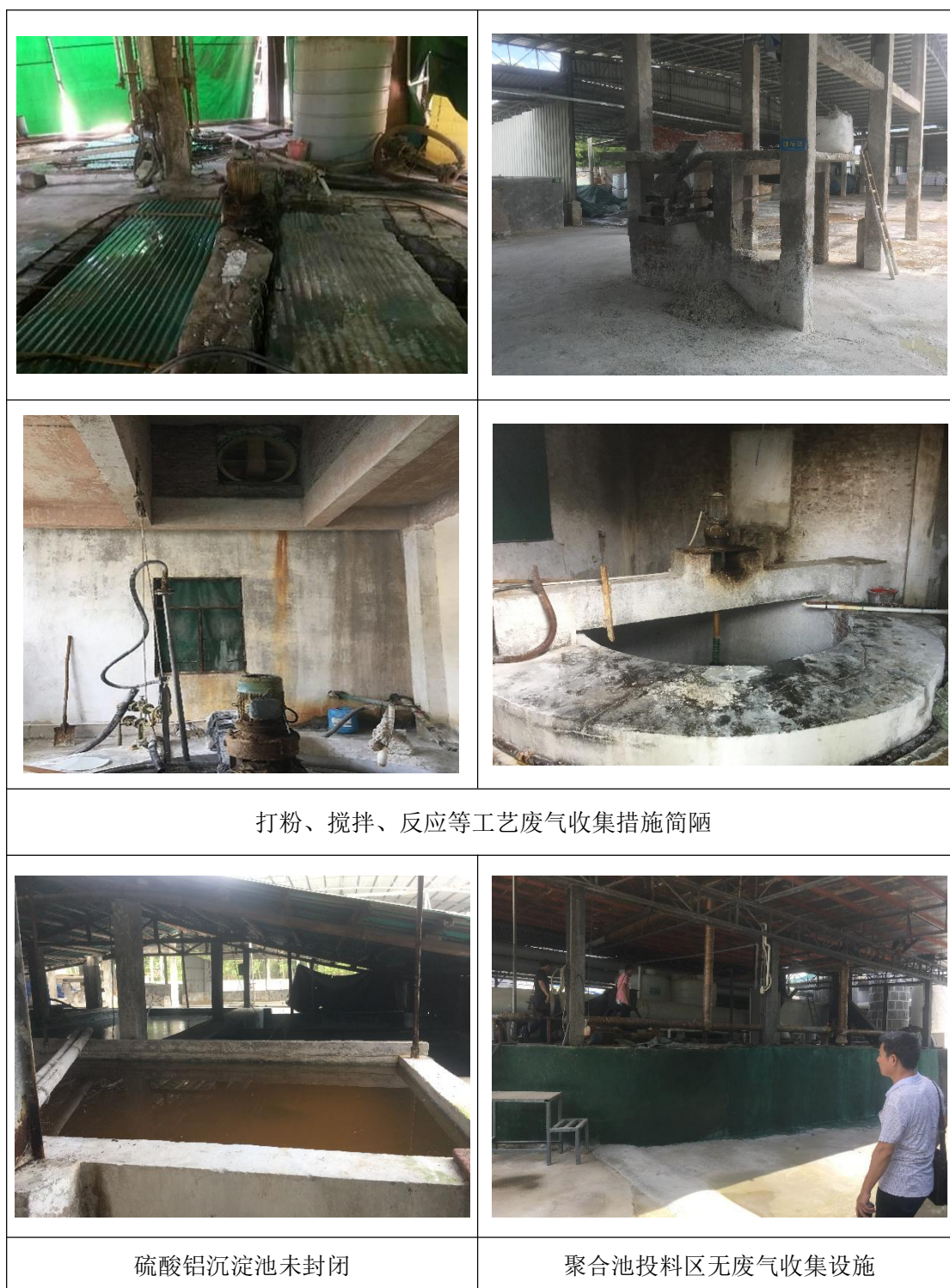
图 3.7-1 现有项目存在的主要环保问题现状实景图
