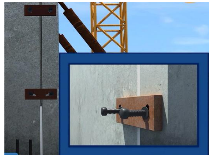
墙板连接件安装、板缝处理
