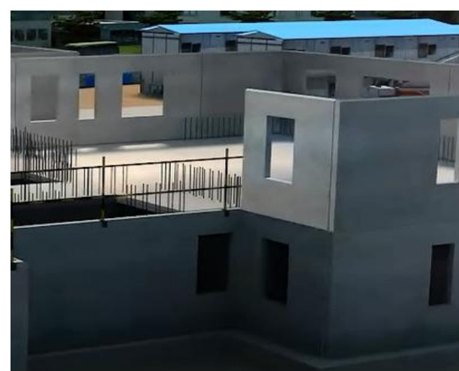
进入上一层结构施工，吊装外墙板
