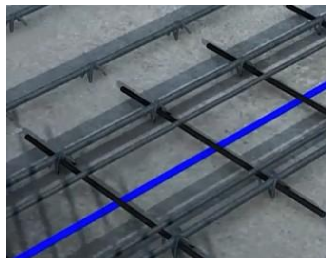
楼板拼缝处抗裂钢筋安装
