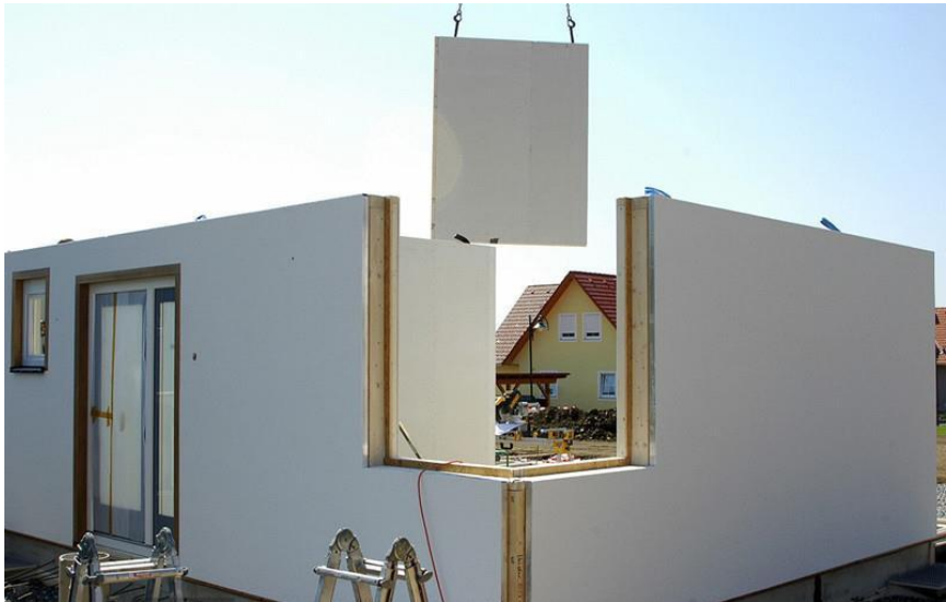
高效的预制件现场施工安装
