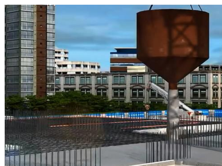
楼板混凝土浇筑
