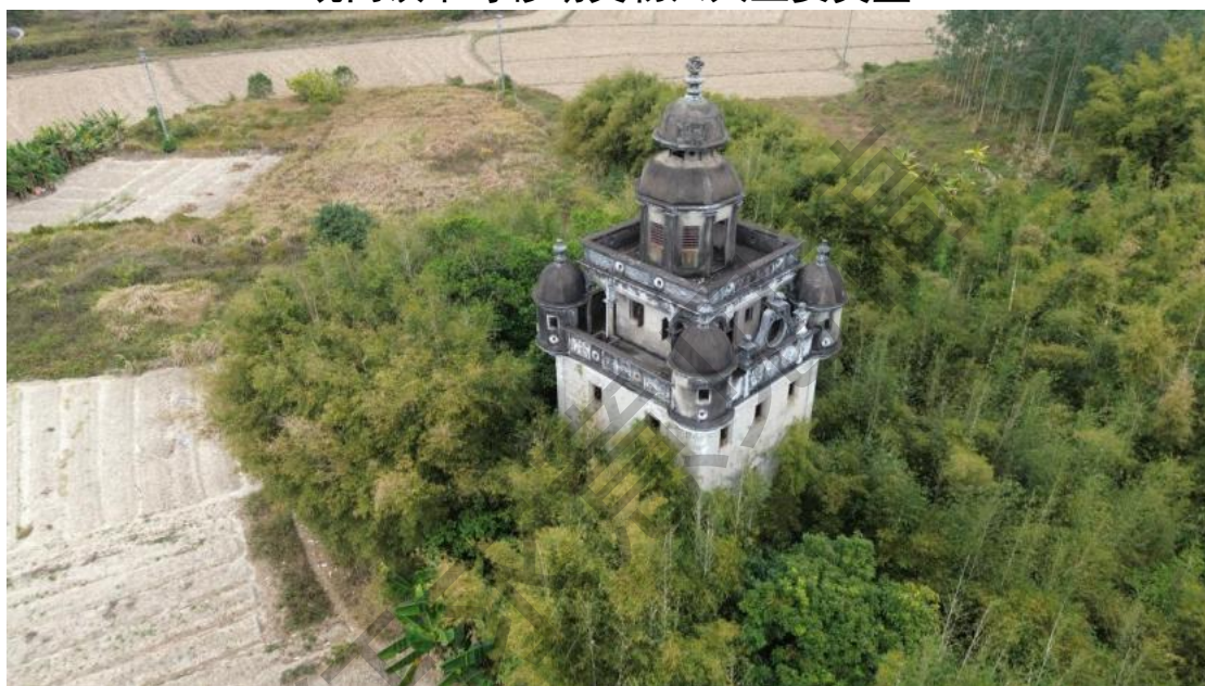
（类型一）典型风格建筑或者构筑物：中兴村庆云楼
