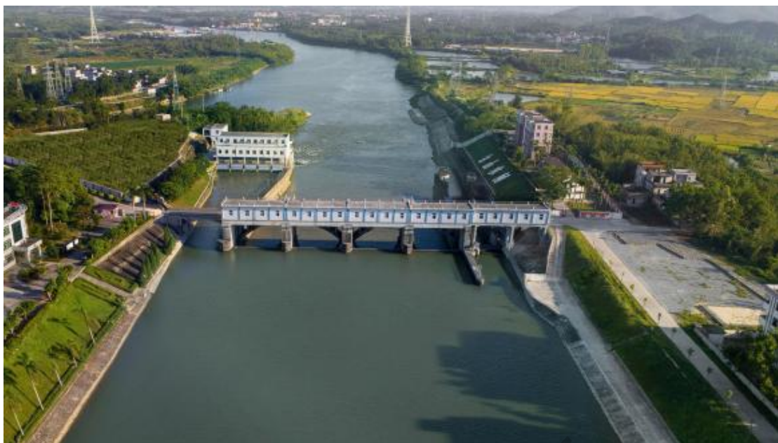
（类型三）水利、农业相关建筑、设施及附属物：合山水闸
