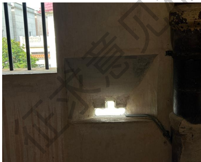
中坚楼内部瞭望孔射击孔
